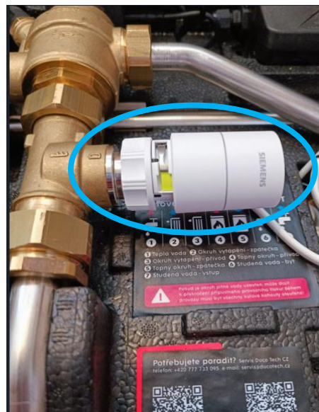
Schéma 14: Elektrotermický pohon ventilu
