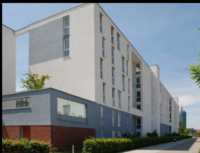
Komplex obytných budov v Max-Friedländer-Bogen v Mnichově s BIOCAT KS 14000, určený pro 110 bytových jednotek
